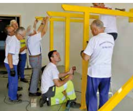
Aménagement local de stockage
